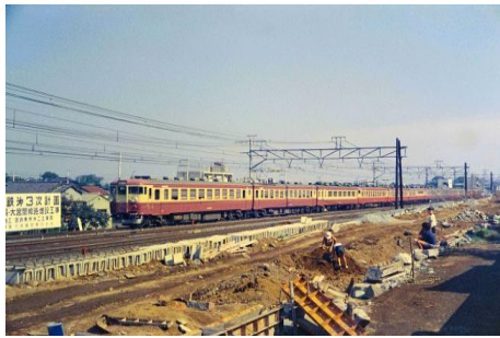
浦和付近での3複線化工事 1966年8月 撮影：志水 茂
