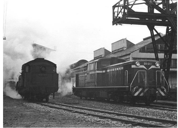
エンジン・変速機を国産とし 非電化区間の無煙化を進めた DD51 形 1963（昭和 38）年
