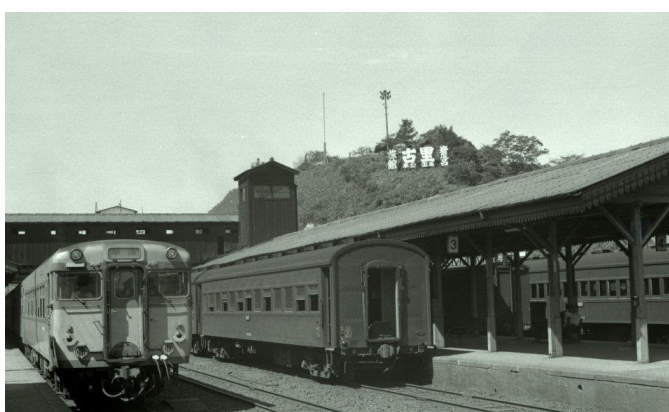
平(現・いわき)駅構内 1962(昭和37)年
