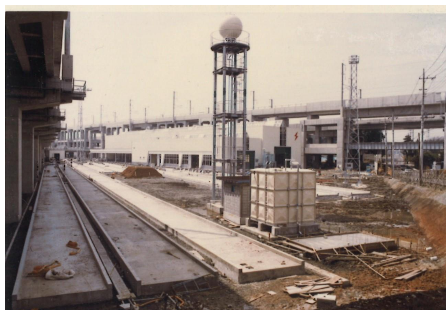
留置線建設風景
