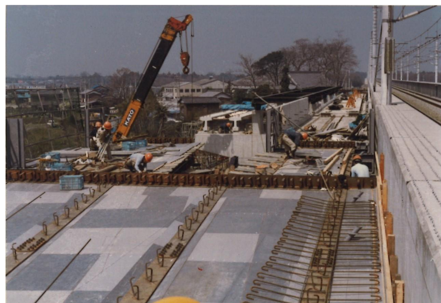
小針駅（仮称・現内宿駅）建設風景
