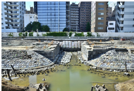
発掘調査により検出された高輪築堤第7橋梁の遺構
