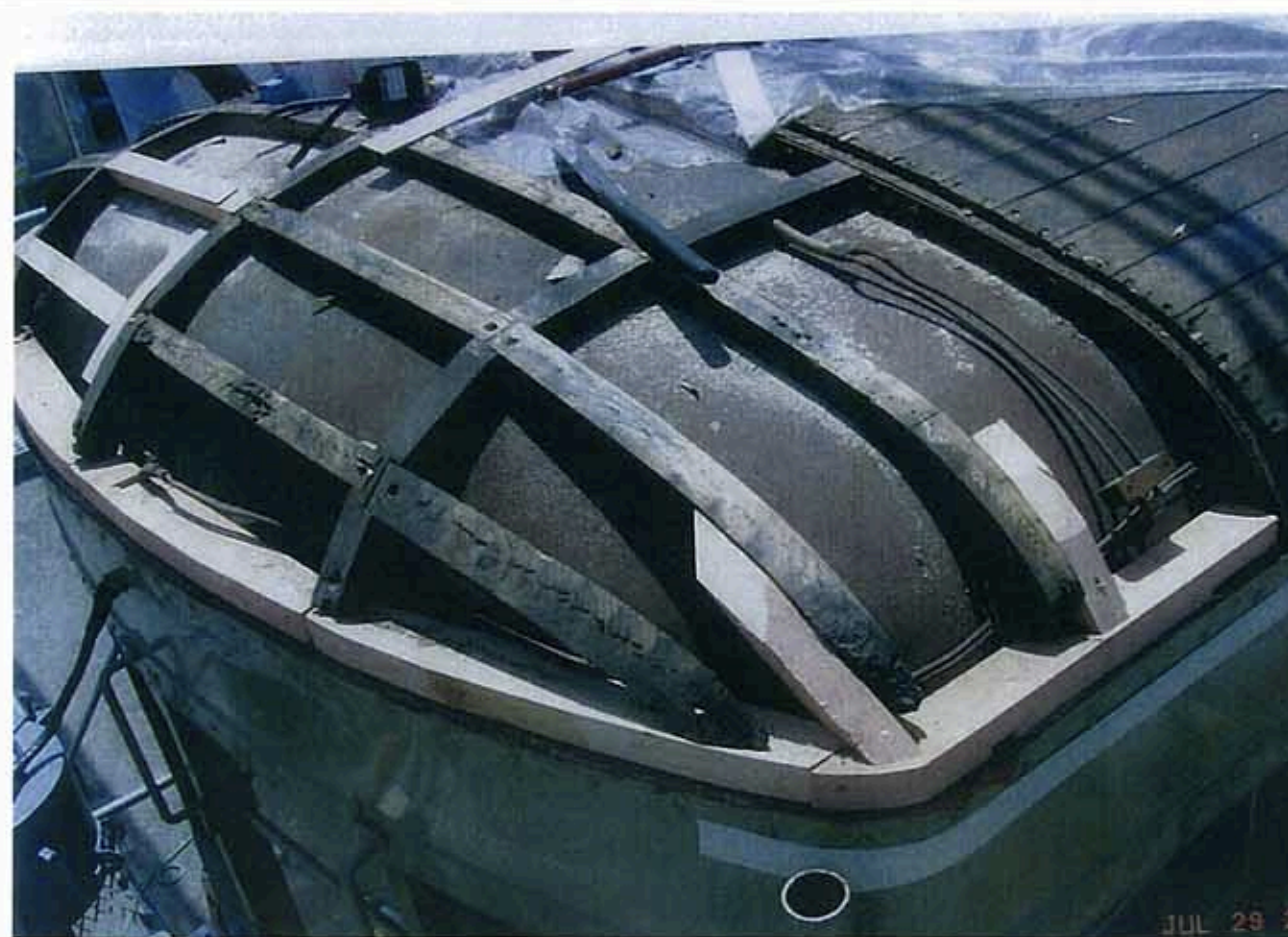
キハ41000形式屋根腐食部補修(06年7月)郡山総合車両センター
