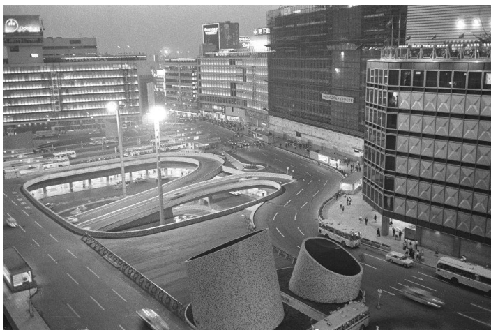
新宿駅西口立体広場 1968(昭和 43)年頃 新宿駅西口に所在した淀橋浄水場は 1965(昭和 40)年に東村山に移転し、跡地は新宿副都心として超高層ビルが建ち並ぶことになる。その玄関となる西口は自動車交通を意識した立体広場が造成され、大繁華街へと発展
