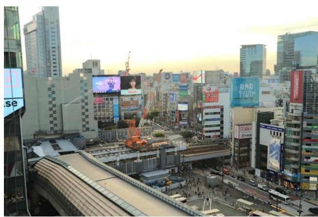
駅周辺の再開発が進む渋谷 2021(令和 3)年 8 月
