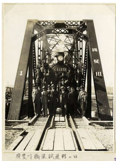
揖斐川橋梁試運転の日 1928(昭和 3)年
