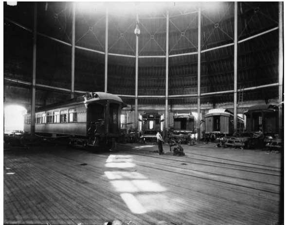
客車工場として稼働していた頃の ラウンドハウス内部
