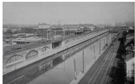
完成した市街高架鉄道(1914年) 東京中心部に優雅なレンガアーチの高架橋が建設された
