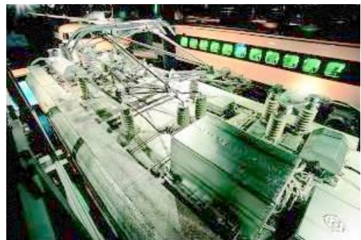
屋根上の集電・切換装置
